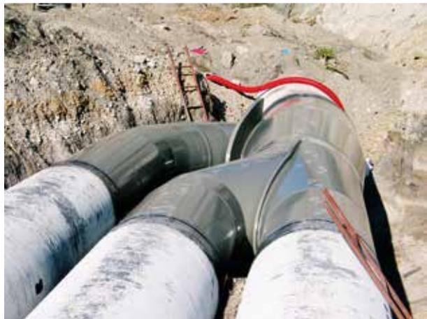
In sintesi la combinazione di tre spessori con tre lunghezze diverse con curve di spessore e raggio diverso a cui si aggiungevano i pezzi speciali per i passi d'uomo e gli attacchi delle valvole di sfiato significava un numero enorme di pezzi diversi (vd. abaco componenti condotta) che, non potendo essere distribuiti lungo il tracciato, dovevano essere prodotti e consegnati secondo una cronologia precisa.
